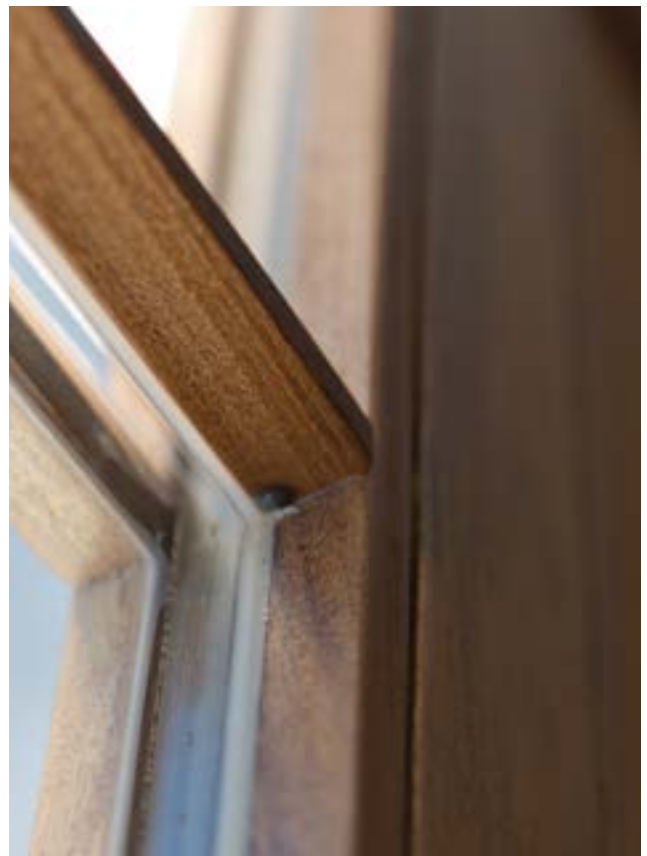
Afwerking onopvallende siliconenvoeg ▶
